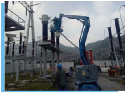
05 浙江紧水滩水电站220kV电流互感器 交流耐压试验
