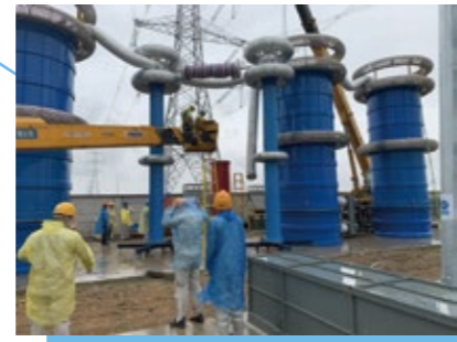
04 配合舟山—镇海500kV海底电缆交流耐压试验
