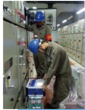
02 新疆浙能阿克苏热电有限公司 1号机组A修6kV开关保护校验
