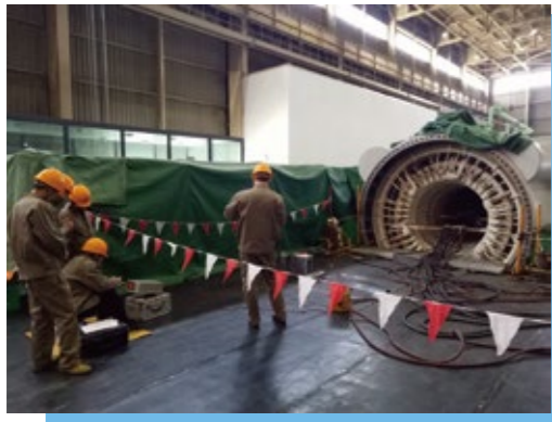
01 浙江北仑电厂 #1发电机定子铁损试验
